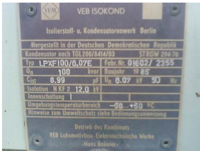
Снимка 4: Фабрична табела на немски РСВ кондензатор (градска подстанция), експлоатиран в България
